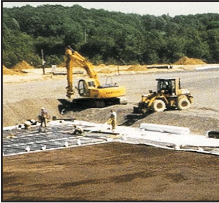
Oberflächenabdichtung Wasserhaushaltsschicht
