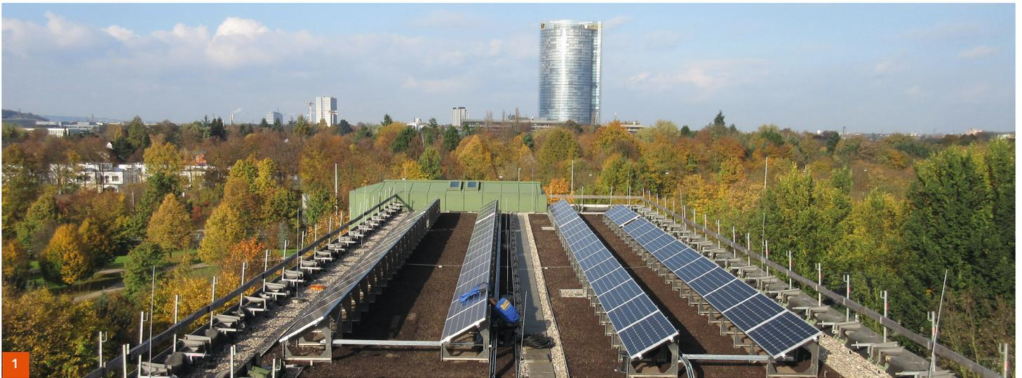
Unsere Planungstätigkeiten basieren auf der umfangreichen Kenntnis aller verfügbaren Technologien und technischen Komponenten einer Photovoltaikanlage. Neben den Modulen selbst gehören alle Nebenanlagen, wie Tragkonstruktionen, Wechselrichter, Kabeltrassen, Messtechnik und der Blitzschutz zu unserem Leistungsspektrum. Für einen wirtschaftlich erfolgreichen Betrieb der Photovoltaikanlage ist die Durchsetzung von Qualitätsstandards unerlässlich.
