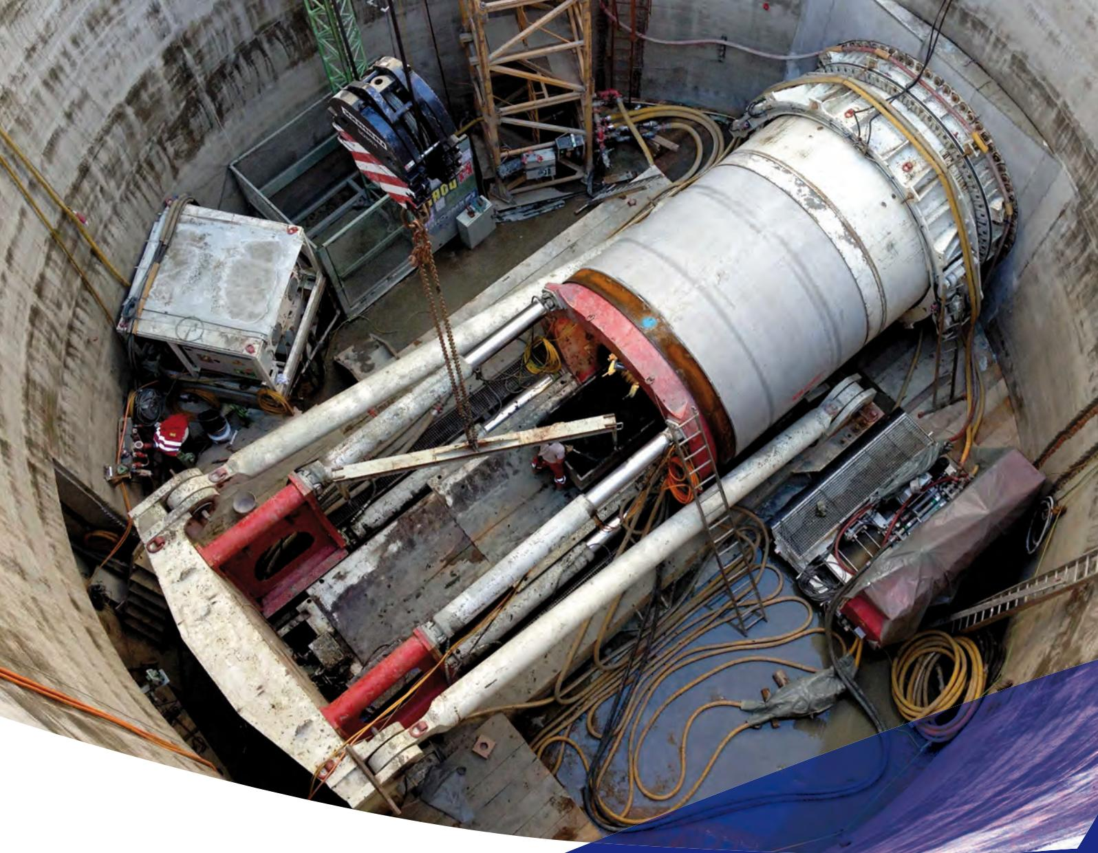
Beim Rohrvortrieb treten verfahrensbedingt hohe Presskräfte auf, die zu Überlastungen und damit zu Rohrschäden in Form von Rissen und lokalen Abplatzungen führen können. In der Folge treten Undichtigkeiten auf, im schlimmsten Fall kommt es zum Versagen der Vortriebsrohre.
